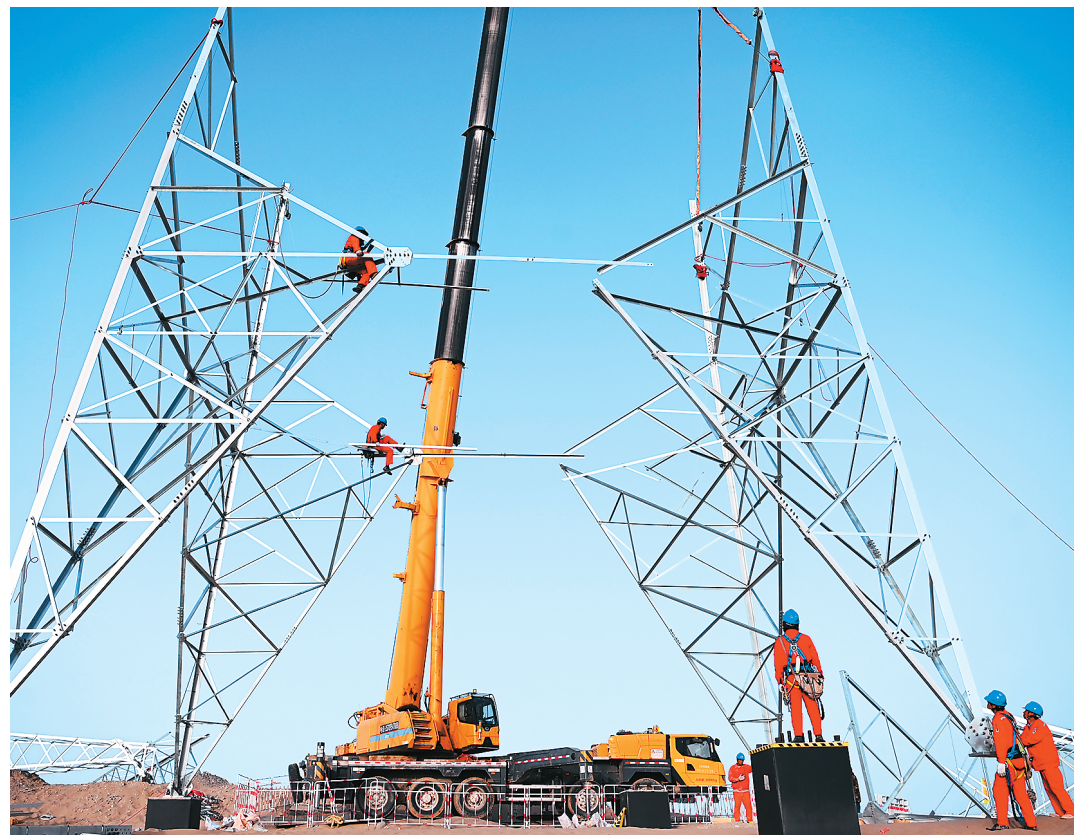
近日，作业人员在新疆若羌县境内的塔克拉玛干沙漠组立铁塔。和田——民丰——且末——若羌七百五十千伏输电工程是新疆用电“十四五”电力发展规划的重点工程，投运后五十多户输电工程将满足南疆地区新增用电和新能源开发建设需求，为疆电外送创造有利条件。 马一元摄（人民视觉）
