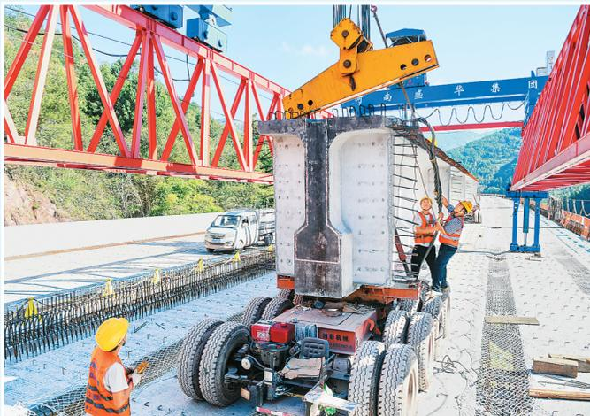
10月18日，随着架桥机将最后一块40米、重140吨的T梁精准平稳地架设在桥墩上，万开达高速公路漆树梁大桥顺利贯通。此次贯通的漆树梁大桥位于重庆市开州区南门镇，采用左右分幅设计，左幅全长851米，右幅全长845.6米，是万开达高速公路的重要节点工程。因为工人在万开达高速公路漆树梁大桥项目作业。
