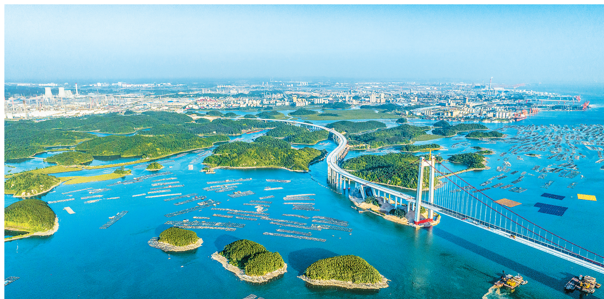
龙门大桥是广西壮族自治区在建的最长跨海大桥,项目路线全长7.637公里,桥梁总长6597米。大桥建成后,将助力北钦防一体化发展和西部陆海新通道建设。图为龙门大桥建设现场。彭 寰摄(人民视觉)
