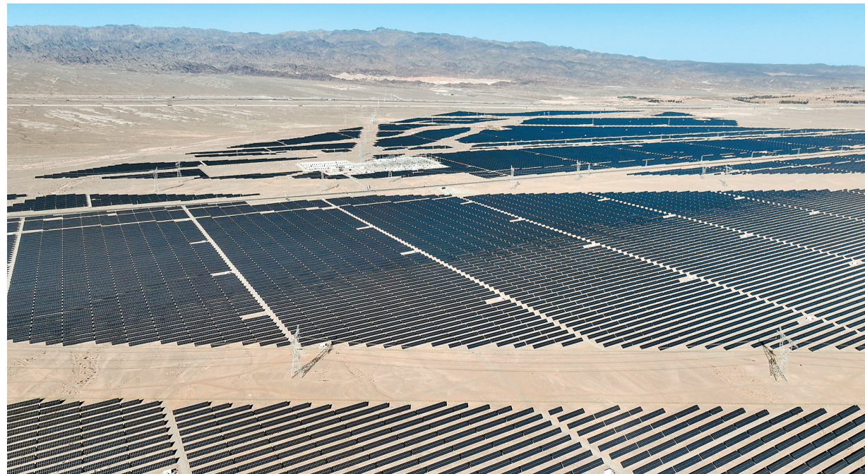
近年来，甘肃省嘉峪关市充分利用资源优势，大力发展戈壁太阳能光伏发电新能源产业，有效促进当地经济发展。图为嘉峪关市戈壁光伏产业园新建的太阳能光伏电站。 马玉福摄（人民视觉）
