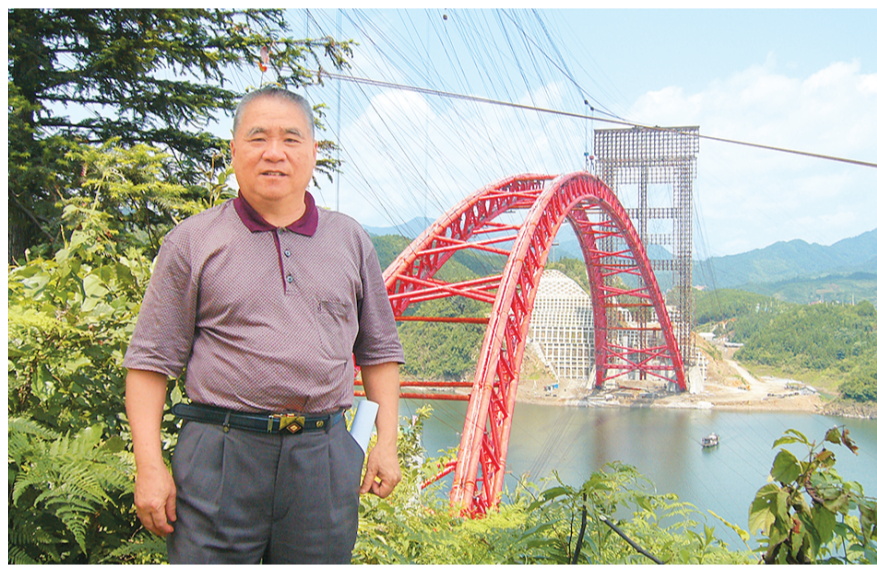
由郑皆连指导建造的安徽黄山太平湖大桥跨径达330米。图为郑皆连在施工现场。
