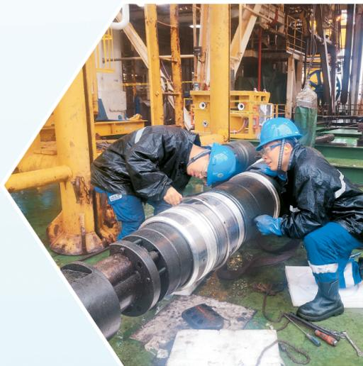
▲ 水下团队在甲板测量油管挂密封尺寸。
