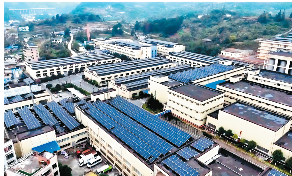
由南方电网贵阳供电局运营的贵州省贵阳市修文贵酒厂屋顶分布式1.8兆瓦光伏电站项目,是贵州省首个10千伏分布式屋顶光伏项目。该光伏电站每年可节约标准煤约606.6吨,减少二氧化碳排放量约1686.1吨。近年来,贵阳市充分利用企业闲置屋顶,推进屋顶分布式光伏建设,大力发展绿色清洁能源,实现经济效益与生态保护双赢。图为9月26日拍摄的贵阳修文贵酒厂屋顶光伏板。周宇摄(人民视觉)
