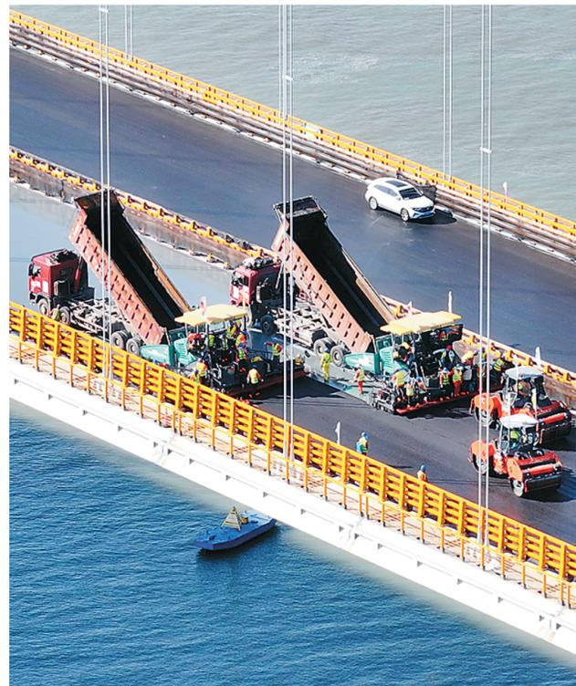
9月23日，龙潭长江大桥主桥桥面沥青铺设施工接近尾声，为全线建成通车奠定基础。龙潭长江大桥北接江苏扬州市仪征市，南接南京市、镇江句容市，双向六车道，全长约5公里，预计在今年底建成，将进一步提升当地交通保障能力。
