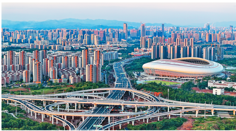
近日，江西省赣州市赣南大道北段、东江源大道北延、沙河大道快速路主线高架建成通车，当地“三横三纵”快速路网通车里程达127公里。图为赣南大道快速路的立交桥。朱海鹏摄（人民视觉）
