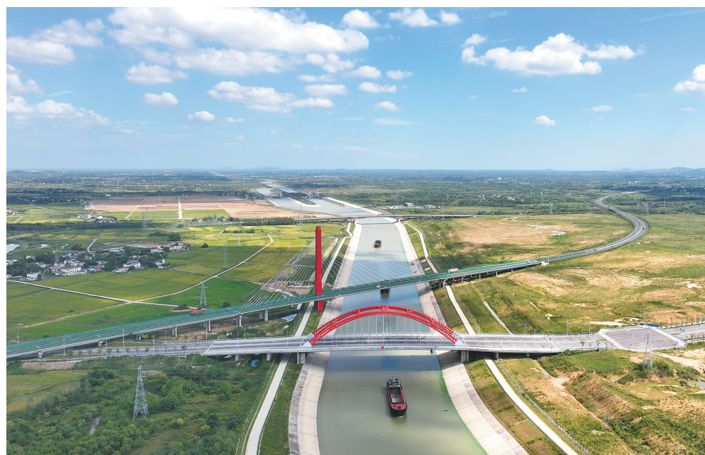
近年来,安徽省合肥市庐江县建设“大交通”,统筹推进公路、水运、铁路等运输一体化发展,高铁、高速、江淮运河形成立体交通,使地理优势变为区位优势,为区域间优化资源配置创造了良好条件。图为9月23日,船舶行经在引江济淮工程庐江县段航道里。
