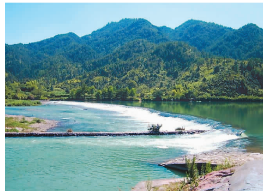
通济堰堰首拦水大坝。 来源：《通济堰申报世界灌溉工程遗产申报书》截图
