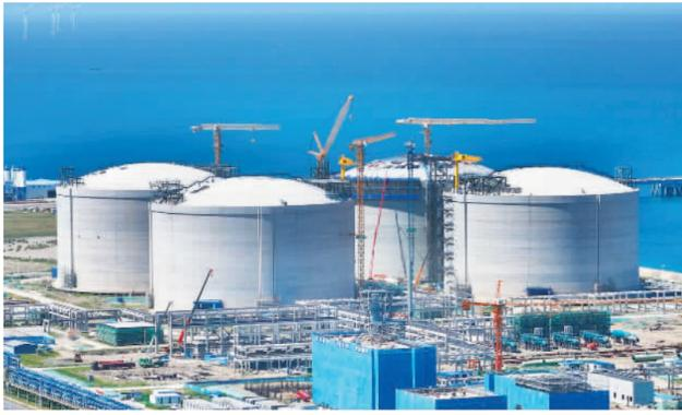
江苏省液化天然气储运调峰工程是该省自主投资建设的第一个接收站项目，项目规划建设4座20万立方米液化天然气储罐及配套设施设备和1座8至26.6万立方米液化天然气专用码头，计划于2025年完工。图为该工程正在建设中。
