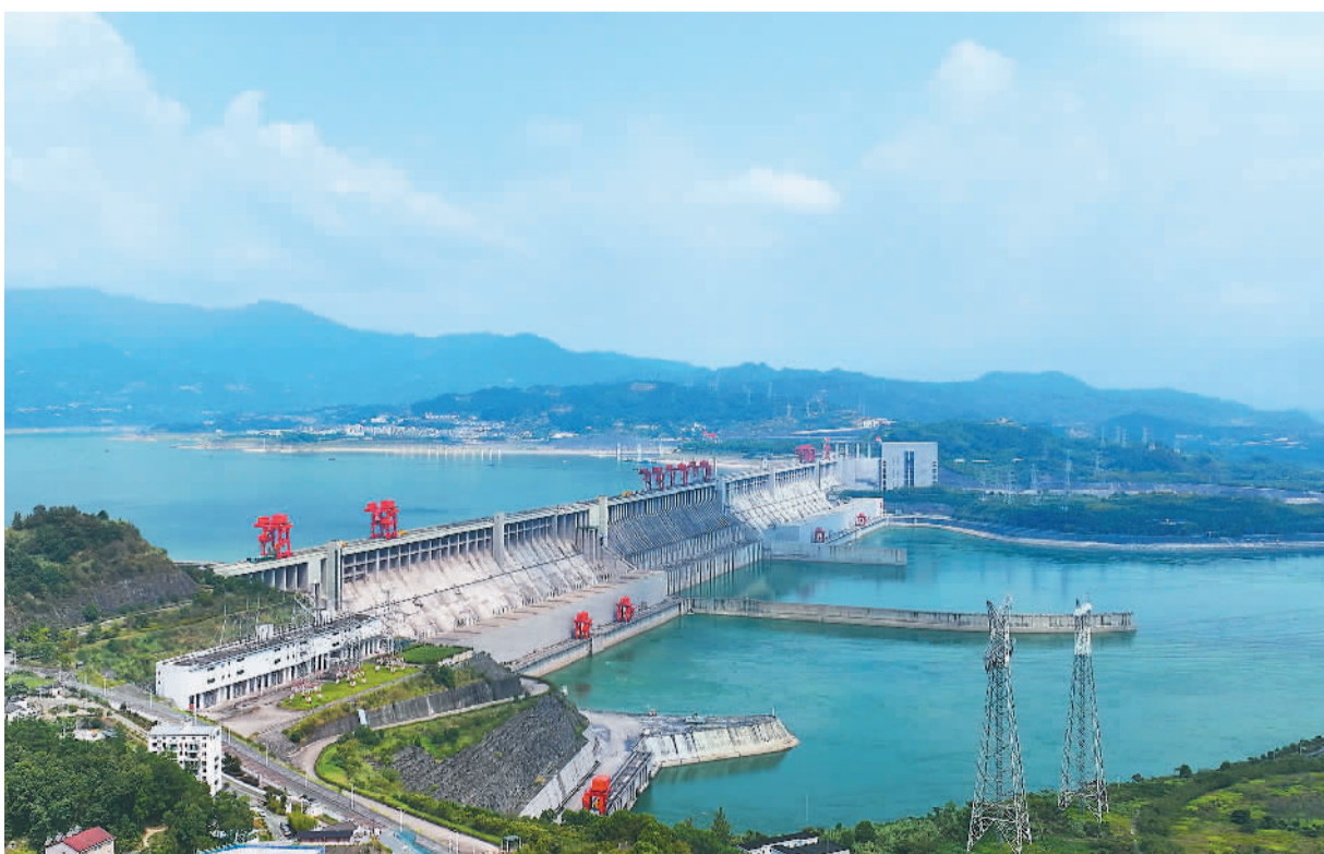
9月10日, 三峡水库正式启动2024年175米蓄水。175米是三峡水利枢纽工程设计的正常蓄水位。三峡水库在每年汛末蓄水, 在枯水期至次年汛前逐渐释放并腾出库容, 以“蓄丰补枯”调度, 为当年冬季和次年春季长江流域的航运、供水、生态、发电等需求提供有力保障。
