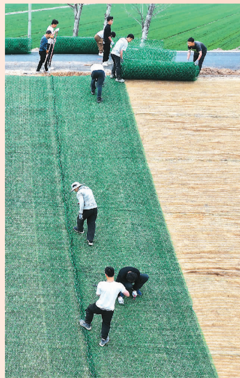
▲施工人员在运城市汾河流域稷山县干流段边坡防护工程施工现场加紧施工。 栗卢建摄（人民图片）
