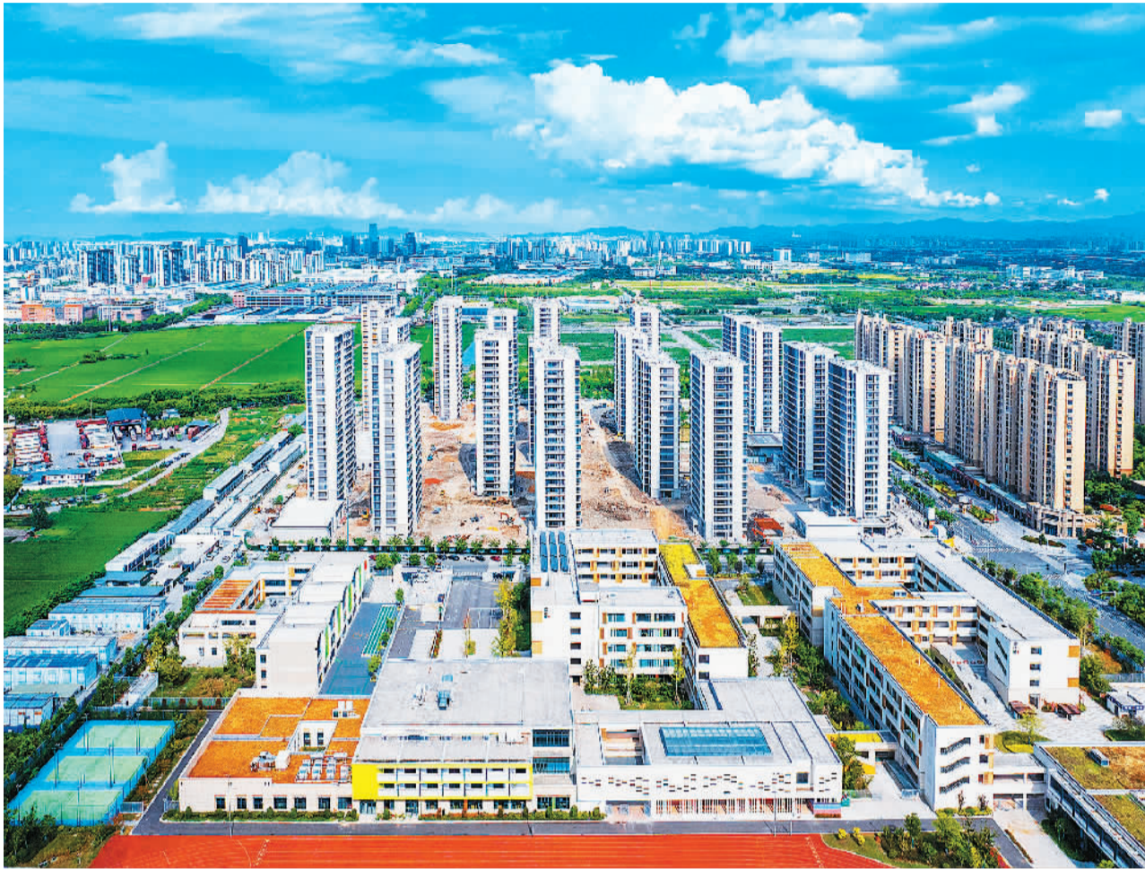
浙江省宁波市统筹推进城市更新，提质加速推进保障房、人才房、青年公寓等项目建设，不断提升住房品质，完善各项配套设施。图为宁波市应家保障房及其周边的学校、地铁等配套设施。
