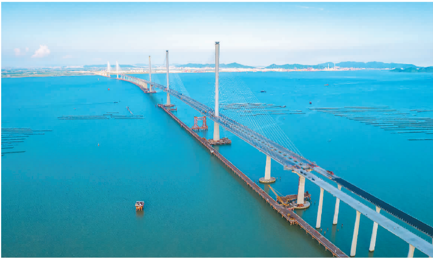
近日，黄茅海跨海通道项目黄茅海大桥已开工建设收尾阶段，黄茅海跨海通道是粤港澳大湾区又一起大型跨海工程，连接珠海市和江门市，线路全长约三十一公里。图为黄茅海大桥建设现场。吕华当摄（人民视觉）
