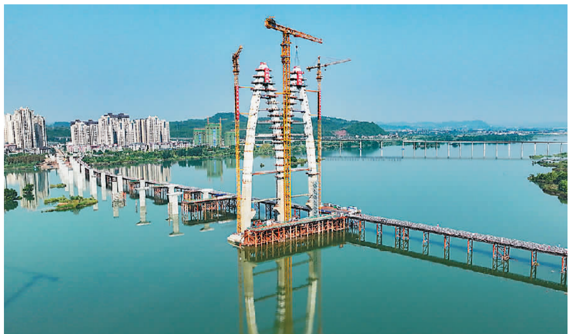
日前，蜀道集团四川路桥桥梁公司承建的四川省遂宁市涪江六桥（袁家坝渡改桥）主塔顺利封顶。该桥是遂宁境内首座斜拉桥，连接涪江两岸城市区域中心，建成后有效缓解跨江交通压力。
