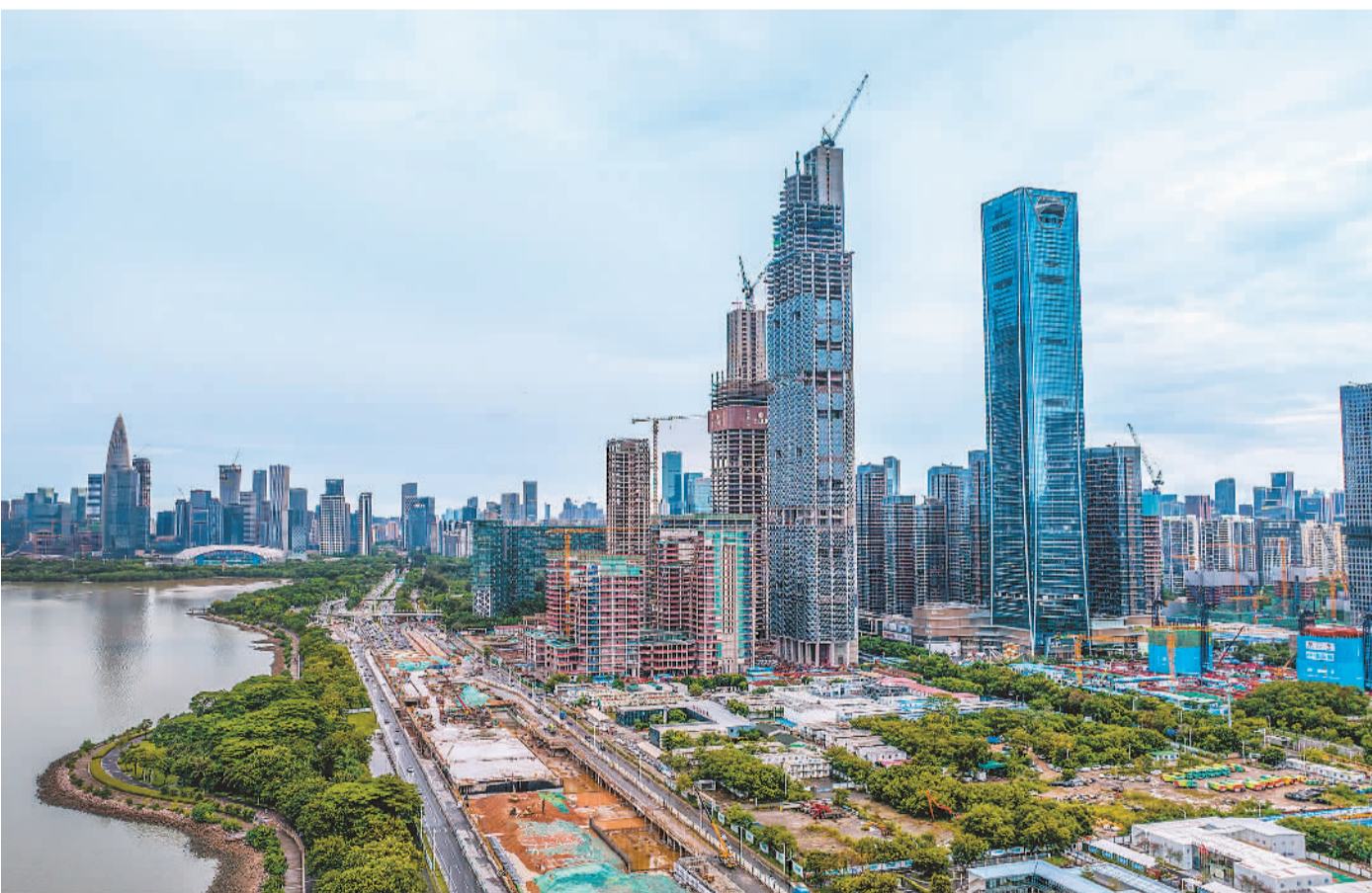
连日来，在位于广东省深圳市南山区的深圳湾超级总部基地内，各项工程正加紧建设。深圳湾超级总部基地毗邻深圳科技园，与香港隔海相望，建成后将成为总部企业和科技企业聚集地。目前，深圳湾超级总部基地片区已吸引一批世界500强及创新科技企业总部入驻。图为建设中的深圳湾超级总部基地。王美燕摄(人民视觉)
