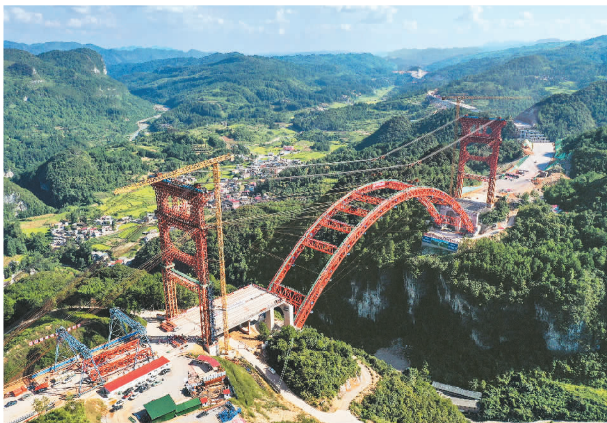
8月21日, 贵阳至平塘高速公路马场河特大桥主拱顺利合龙。该大桥位于贵州省贵定县盘江镇马场河村, 全长381.5米、主跨260米, 桥面设计为双向六车道, 是G7522贵阳至北海高速公路贵阳至平塘段控制性工程。
