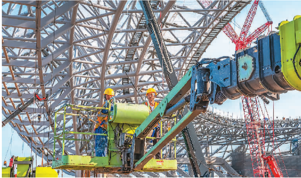
建设正如火如荼展开。图为工作人员正在施工。 王美燕摄（人民视觉）
