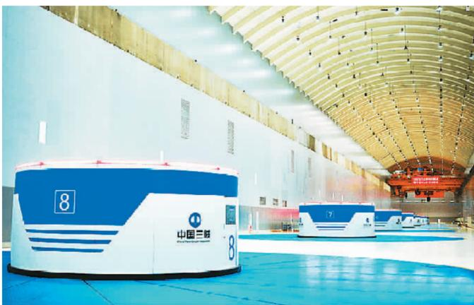
▲白鹤滩水电站地下厂房内的水轮发电机组。
