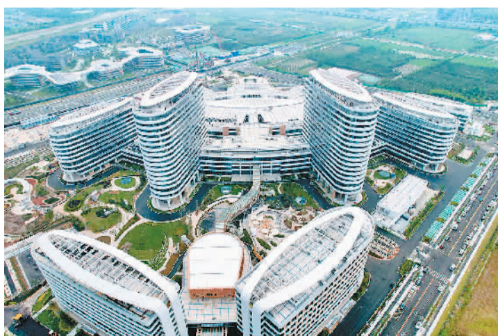
日前，中建八局承建的浙江大学医学院附属邵逸夫医院（绍兴院区）项目启动试运行。项目总建筑面积约38万平方米，是浙江省重点民生工程，也是浙江省级优质医疗单位与县区政府合作办医新模式，旨在打造集“医、教、研、防、养”五位一体的三级甲等综合医院，将成为绍兴市生命健康事业新高地。孙佳璇摄
