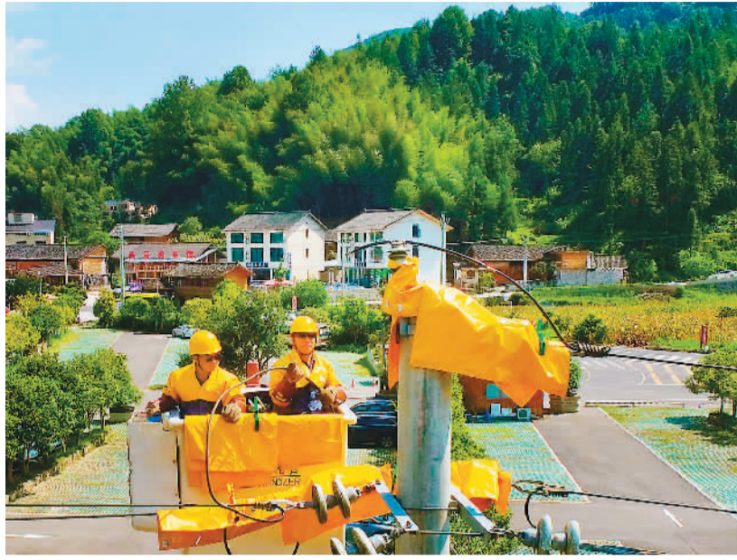
近日，贵州省铜仁市由于持续高温，电力需求稳步增长，南方电网贵州铜仁供电局持续开展带电作业扩容扩容工作，全力保障工业、农业、居民安全用电。图为该局工作人员正在作业。 吴 瑾摄（人民视觉）
