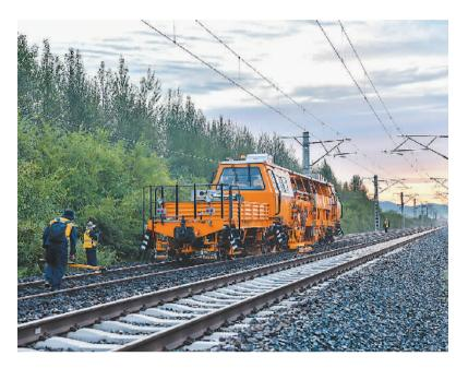
通(通辽)霍(霍林河)铁路是中国东北露天煤矿——霍林河煤矿向外输送能源的交通大动脉。中国铁路沈阳局集团有限公司对通霍铁路实施线路清筛、更换钢轨、应力放散等大中修施工,全面提升线路基础质量,确保运输安全。图为近日,通霍铁路哈日努拉站至西哲里木站间线路清筛施工现场。 李季春摄(人民图片)
