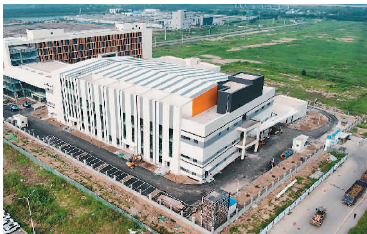
近日,天津滨海新区电子芯片研发平台基础设施项目顺利竣工。该项目由中建五局承建,助力新质生产力发展。
