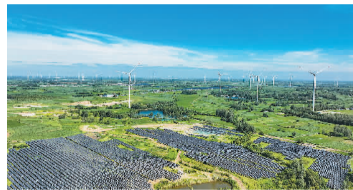
江苏省宿迁市泗洪县双沟镇风力、光伏发电设备。 刘 焯摄（人民视觉）
