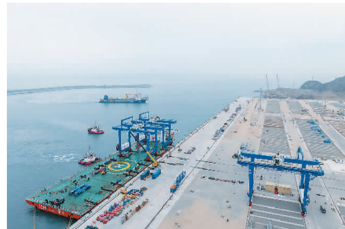
秘鲁钱凯港码头操作区。 新华社记者 李木子摄
