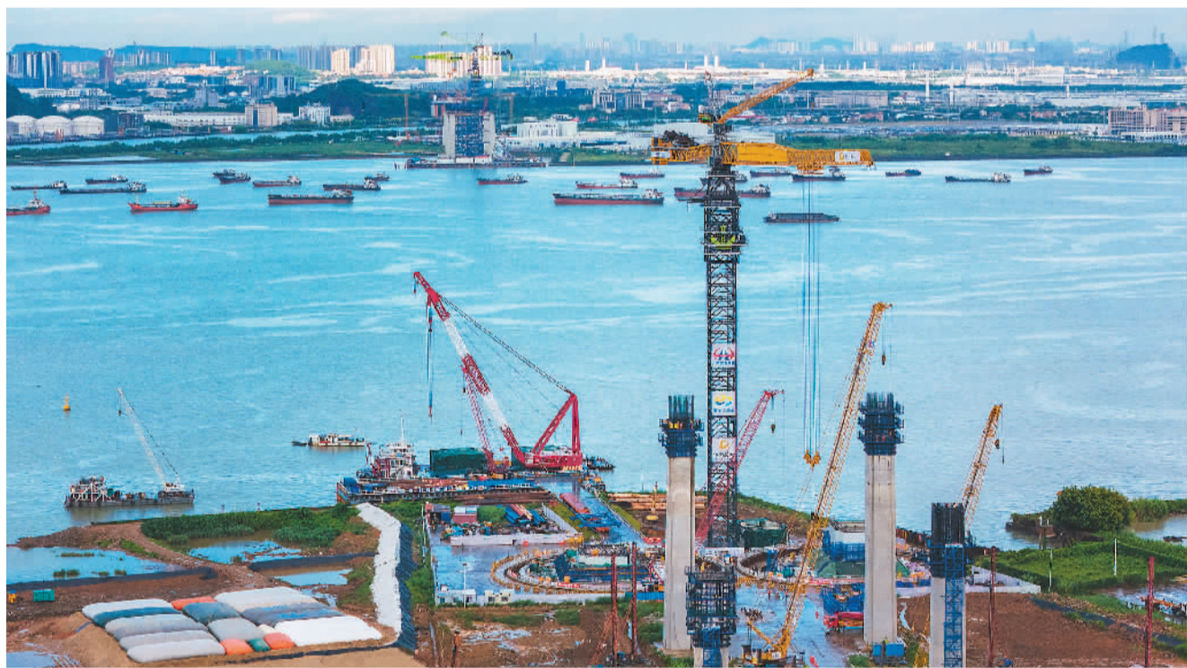
连日来，广州南沙狮子洋大桥工程建设如火如荼，现场塔吊林立、机器轰鸣。狮子洋大桥采用主跨2180米双层钢桁悬索桥的方案“一跨过江”，是粤港澳大湾区又一超级工程——狮子洋通道的控制性工程，计划2028年建成通车。图为狮子洋大桥建设现场。邱新生摄（人民视觉）
