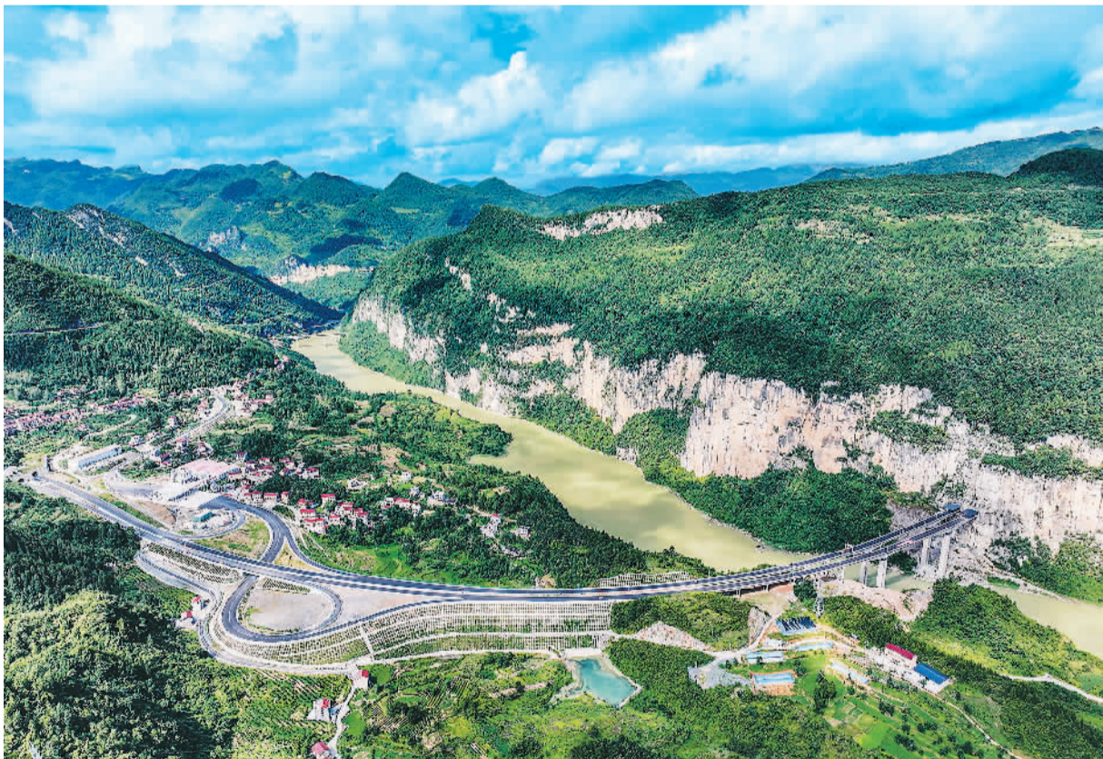
目前,渝湘复线高速彭水路标段进入收尾施工阶段。渝湘复线高速公路总里程280公里,由巴南至彭水、彭水至酉阳、武陵至道真三条路组成。全线建成后,将缓解既有渝湘高速拥堵状况。图为渝湘复线高速彭水路标段建设现场。
