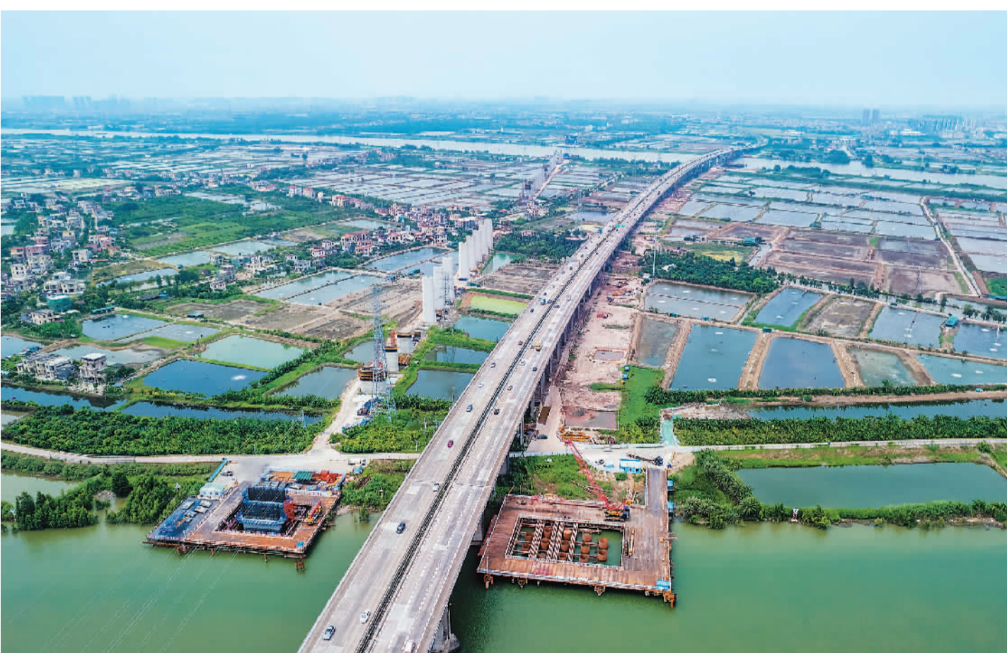
连日来，广澳高速改扩建项目有序推进。广澳高速公路是国家高速G4的并行线之一，也是第一条由内陆直接通往澳门的高速公路。广澳高速南沙至珠海段改扩建项目于2022年11月开工建设，计划2027年全线建成通车。图为位于广东省中山市的广澳高速改扩建项目关键性控制工程海隆大桥施工现场。吕华当摄（人民视觉）
