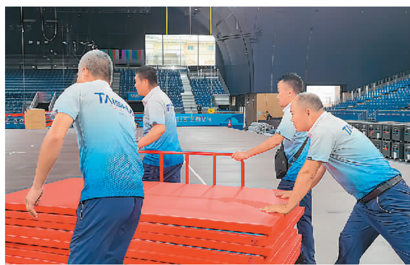
在法国巴黎战神广场竞技场，工人在为安装运动垫做准备。
