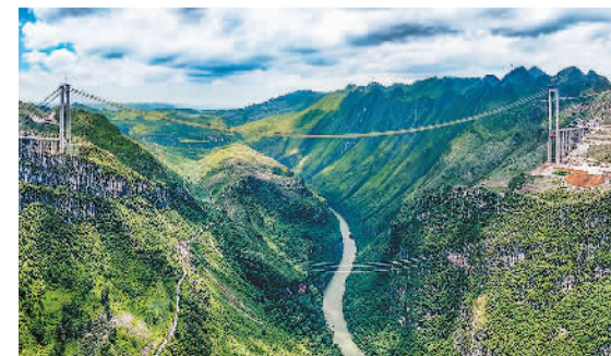
7月7日，建设中的花江峡谷大桥。
