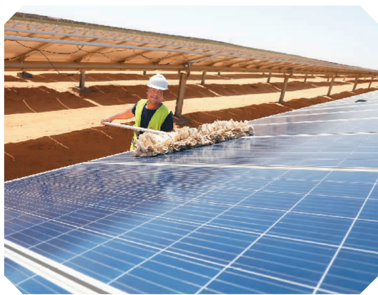
图为在埃及阿斯旺省的本班光伏产业园，工人对光伏组件进行尘土清除工作。 艾哈迈德·戈马摄（新华社发）
