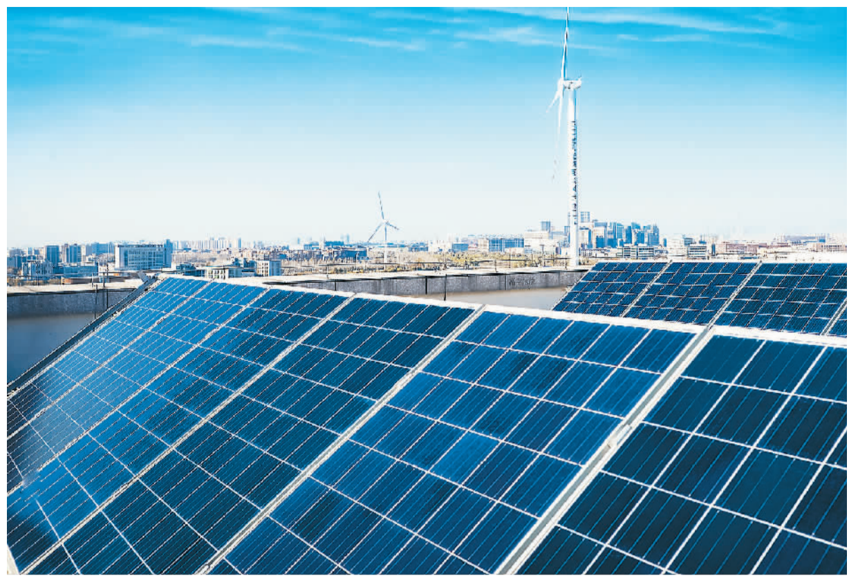
金风科技亦庄智慧园区屋顶的光伏板。
