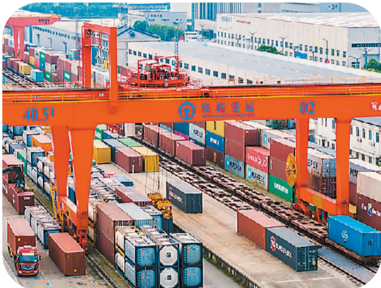
▲7月13日，在江苏省海安商贸物流产业园铁路物流基地内，大型起重设备进行集装箱装运作业。
