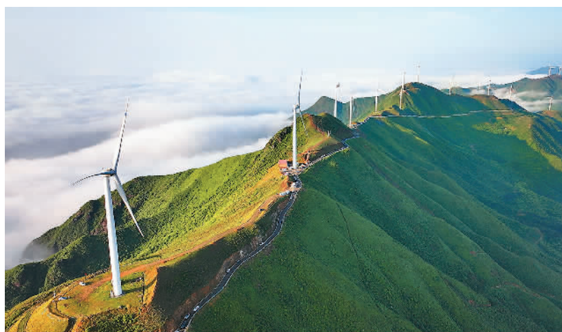
在江西省吉安市遂川县左安镇洋溪村俯瞰双溪山，数十台风力发电机电迎风旋转。
