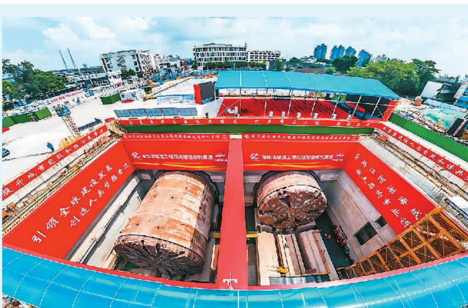
7月15日,由广州交投集团投资建设、中铁十四局承建的广州海珠湾隧道实现双洞贯通,标志着广东省重点项目取得重要进展。海珠湾隧道工程全长4.35公里,总投资约116.8亿元,其中盾构段长2102米,设计为双管双向6车道,采用两台开挖直径15.07米的泥水平衡盾构机施工,为广州第一条超大直径盾构隧道。
