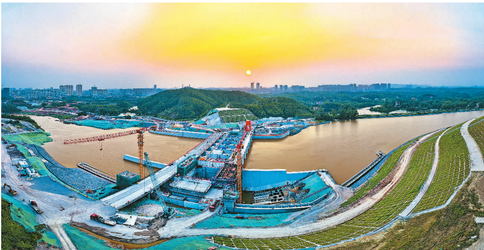
▲平陆运河青年枢纽泄洪闸全景。
