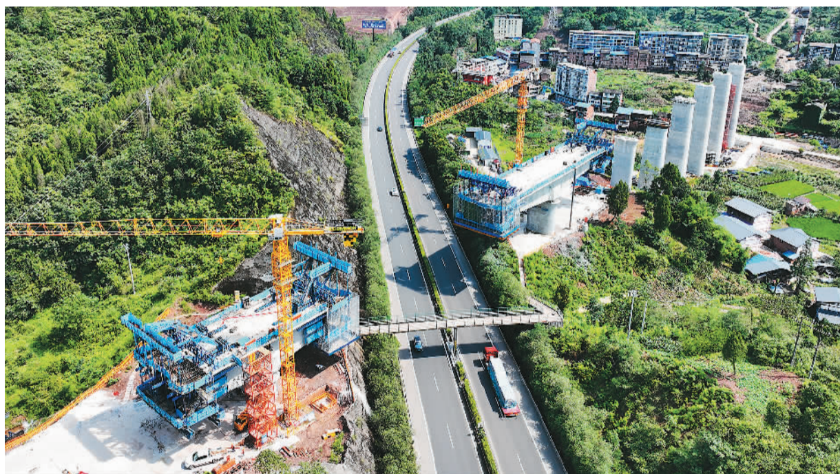
西渝高铁是我国“八纵八横”高铁网京昆通道和包(银)海通道的重要组成部分,设计时速350公里。项目建成后,将推动中西部地区路网结构进一步完善。图为7月16日,在四川省达州市高新区西渝高铁墩塘特大桥施工现场,建设者正加紧施工。许达摄(人民视觉)
