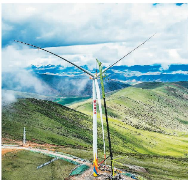
本报北京7月10日电（记者丁怡婷）7月10日，藏东南高原，随着汽车吊将重达110余吨的风机叶轮组件缓缓吊至110米高空与机舱精准对接，世界在建最高海拔风电项目——大唐西藏八宿100兆瓦保障性并网风电项目首台风机吊装作业完成。
