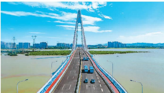
由中交二航局承建的湖南长沙香炉洲大桥日前正式开通。香炉洲大桥是湘江上跨度最大、主塔最高的独塔斜拉桥，项目主线全长3.24千米，为双向六车道城市主干路，是湘江流域首座按照I级航道标准设计的独塔斜拉桥。大桥主塔高202米，是湘江上桥梁最高高度。图为长沙香炉洲大桥。康朴 向昌文 摄影报道
