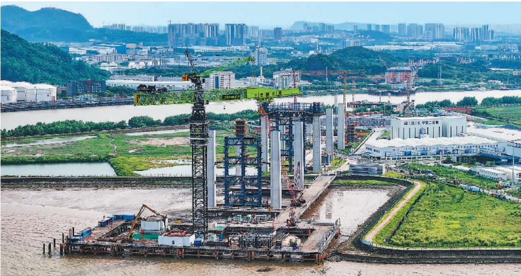
连日来，广州南沙狮子洋大桥工程建设如火如荼。狮子洋大桥采用主跨2180米双层钢桁悬索桥的方案“一跨过江”，是粤港澳大湾区又一超级工程——狮子洋通道的控制性工程，计划2028年建成通车。图为狮子洋大桥建设现场。
