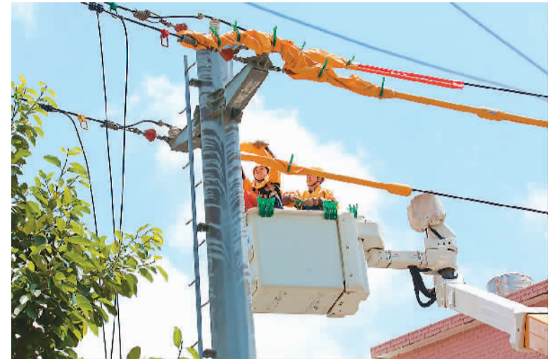
进入7月，广西壮族自治区玉林市各地用电负荷攀升。南方电网玉林供电局通过增加不停电作业范围和频率，在主动做好电力线路日常运维的同时，最大限度减少用户停电时间，全力保障迎峰度夏期间居民用电稳定。图为7月8日，该局工作人员对10千伏古城I线进行带电消缺作业，整个作业过程用户“零感知”。 余晨摄（人民视觉）
