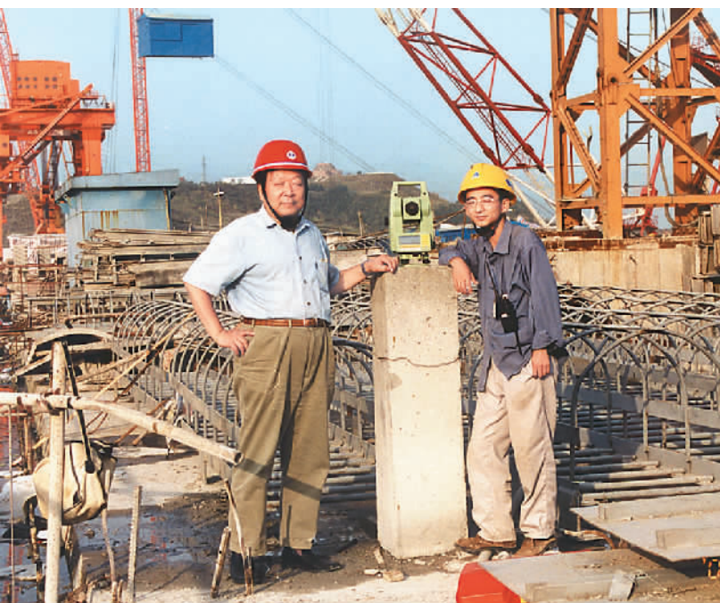
▲2002年10月，李德仁（左）在三峡大坝建设工地。
