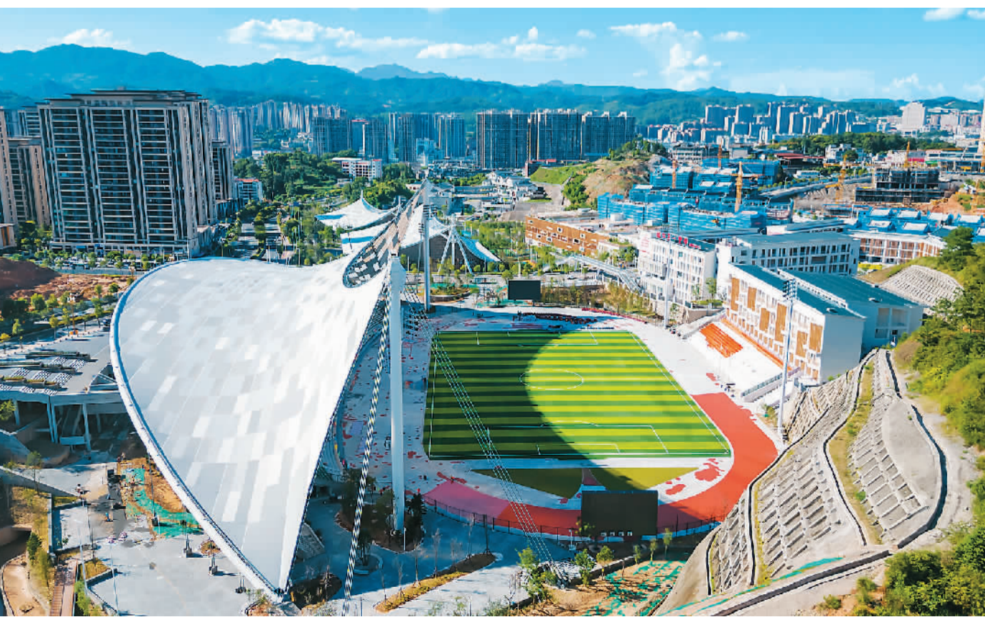
连日来，位于福建省泉州市德化县的霞田文体园体育场馆项目建设持续推进。该体育场以“蔓藤城市”为设计理念，总建筑面积1.7万平方米，可容纳1.1万人，内设武术馆、散打馆、跆拳道馆、击剑馆、乒乓球馆等专业运动馆及辅助用房。
