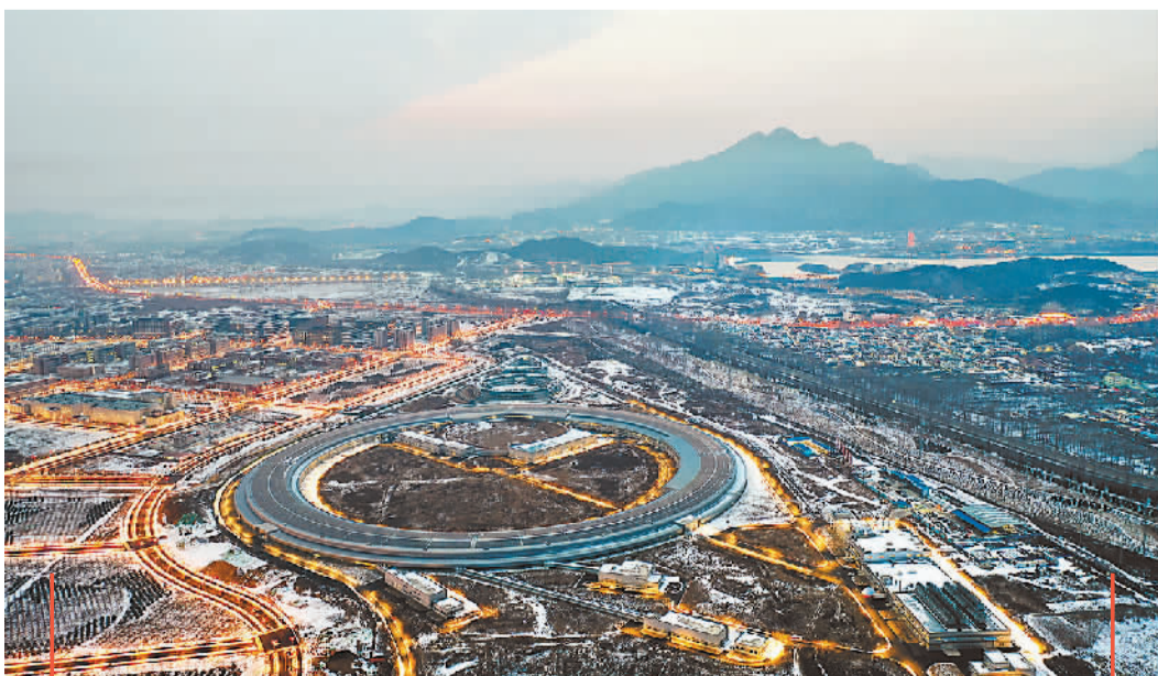
日前，国家重大科技基础设施高能同步辐射光源（HEPS）的储存环完成全真空闭环，标志着储存环全环贯通，进入联调阶段。高能同步辐射光源储存环束流轨道周长约1360.4米，用于储存高能高品质电子束，同时产生同步辐射光，是世界上第三大光源加速器、国内第一大加速器。
