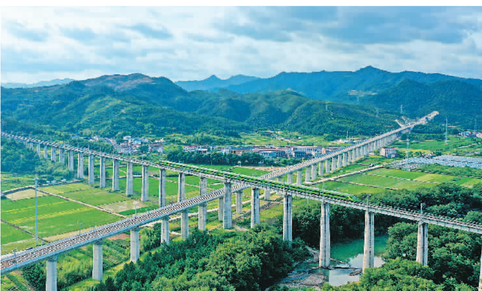
7月2日，列车驶过浙江省台州市仙居县田市镇的高架铁路。近年来，仙居县不断加大交通基础设施建设，打造铁路、高速公路、城乡公路等为一体的立体交通网络，推动城乡协同发展。
