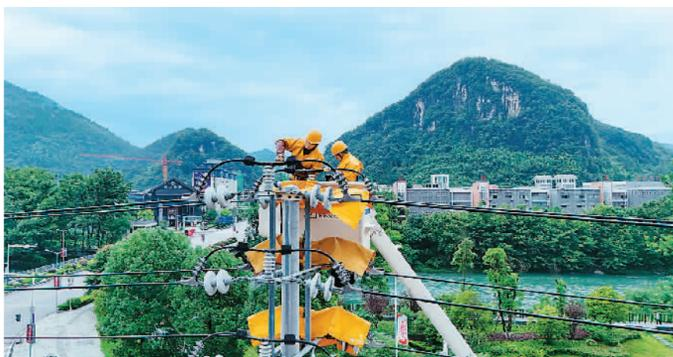
进入汛期以来，受持续高温天气影响，居民用电负荷激增。为保障群众汛期安全稳定供电，南方电网贵州铜仁供电局靠前服务，组织工作人员对配网线路加强巩固运维，提升供电能力。图为6月29日，在贵州省铜仁市江口县闪考镇，工作人员在江口县10千伏闪考线路上进行带电检修作业，保障1866户居民和16家企业的停电影响零感知。吴瑾摄(人民视觉)
