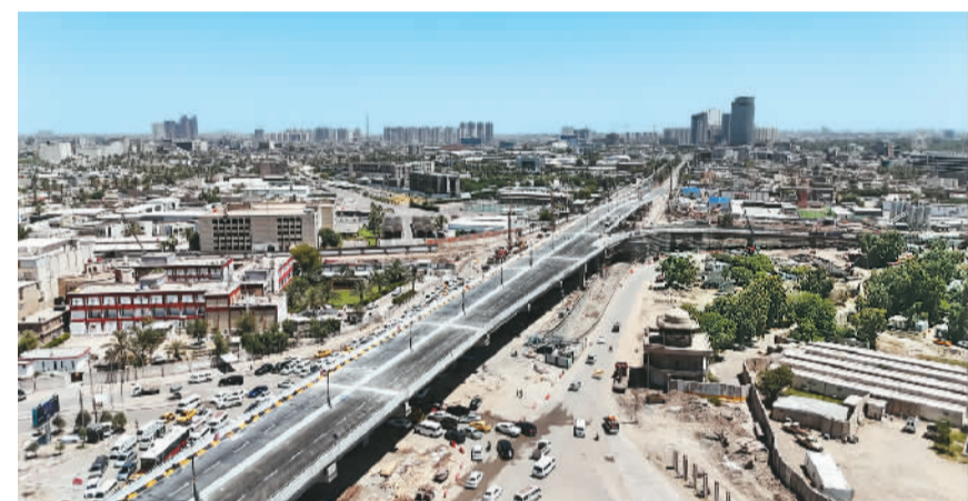
日前，由中铁国际设计施工的伊拉克巴格达尼苏尔立体交通枢纽工程尼苏尔主桥按期通车运营。该项目是促进伊拉克首都巴格达稳健发展而推出的首批一揽子提经济、惠民生的重要组成部分，将有效缓解尼苏尔片区交通拥堵情况。
