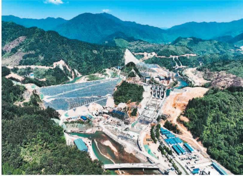
位于浙江省衢州市的开化水库工程是国家重大水利工程之一，总投资45.5亿元，总库容1.84亿立方米。图为开化水库工程施工现场。
