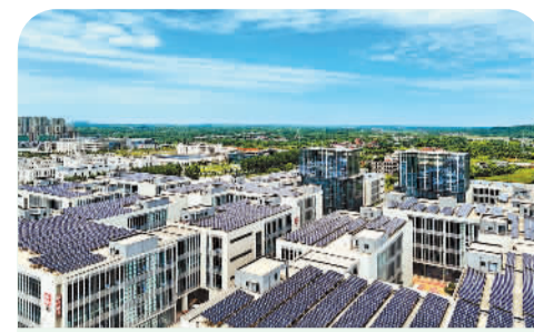
在江西省赣江新区中医药科创城创新示范基地，屋顶布满了太阳能光伏组件。 袁骏摄（人民视觉）
