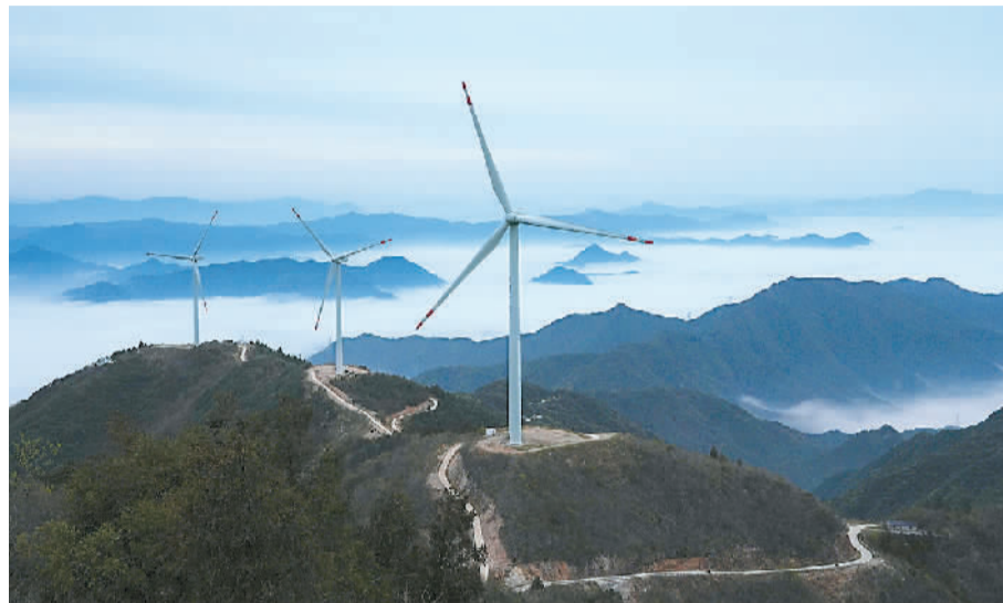
浙江省台州市三门县坎水山风电场的风电机组。 林利军摄（人民视觉）
